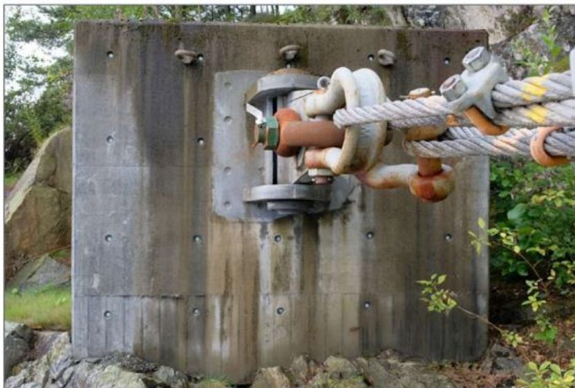
Figur 2-15 Eksempel på eksisterende ankerfester, nye ankerfester vil kunne få tilsvarende utforming.
