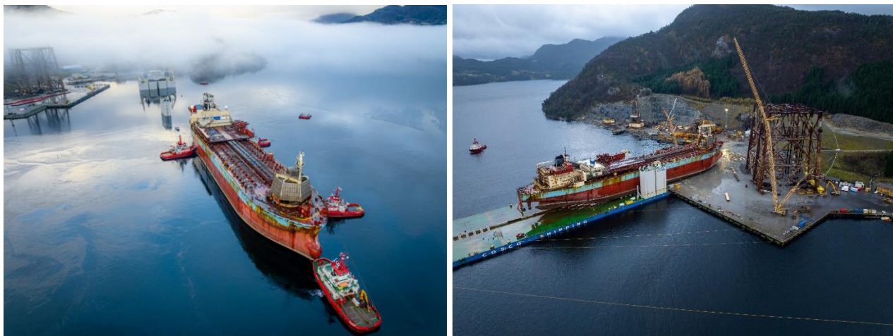
Figur 2-4 T.v. skipsanløp ved miljøbasen. T.h. innlasting av 230 m langt produksjonsskip
