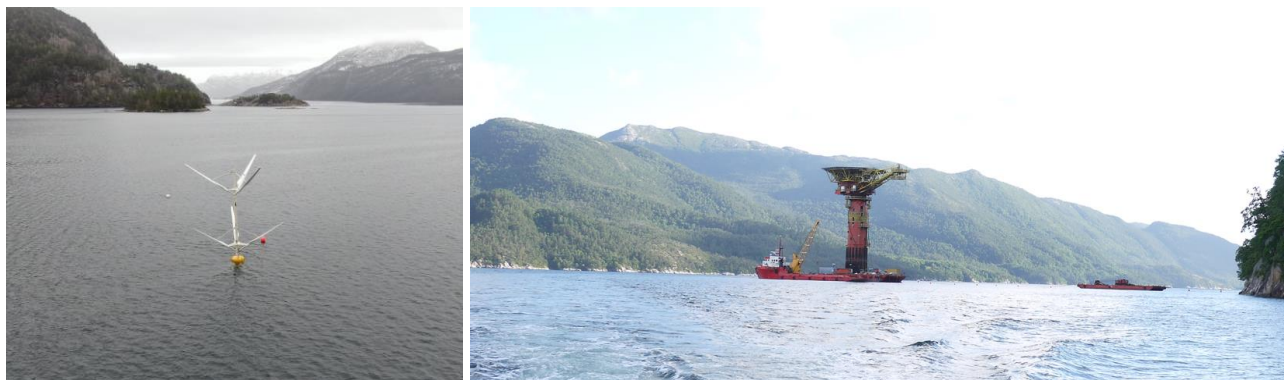
Figur 4-12: T.v. oppankring av flytande vindturbin i Vatsfjorden 2024. T.h. oppankring av SPAR-bøye med 134 m djupgang i Yrkefjorden.
