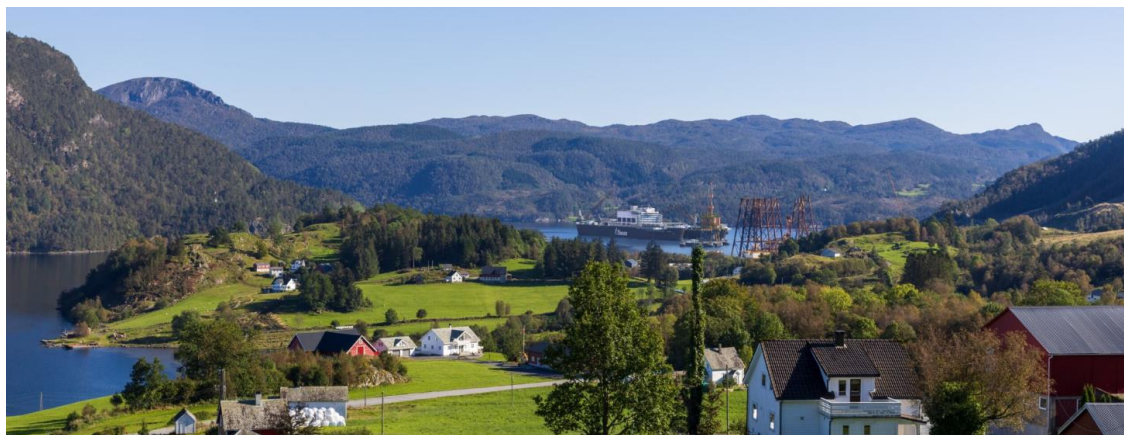
Figur 6-6. Eksempel på aktivitetar i sjø ved seksjonering av installasjonar.
