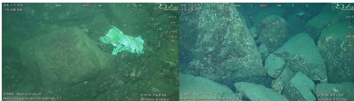
Figur 2-11. Eksempler på modifiserte områder med eldre og nyere steinfyllinger ved og i nærheten av eksisterende kai-konstruksjoner.
