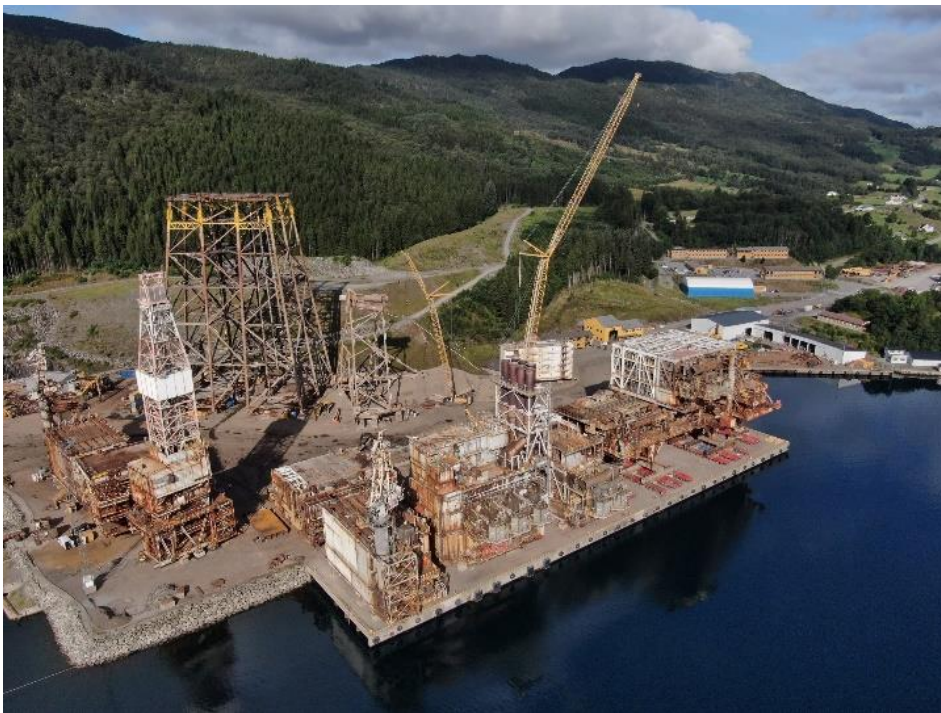
Figur 2-4. T.v. seksjonering av fortøyd skip med kran og 50 tonns rivemaskin. T.h. demontering av oljeinstallasjoner.
