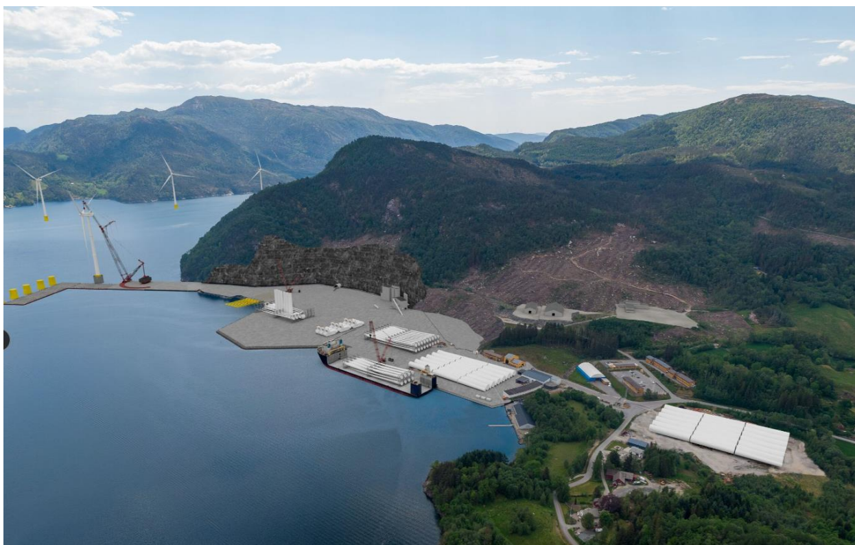
Figur 2-16 Visualisering av anlegg tilrettelagt for produksjon av vindturbiner med SPAR-fundamenter. For montering av vindturbiner benyttes en ca. 190 m høy kran, som plasseres ytterst på kaien.
