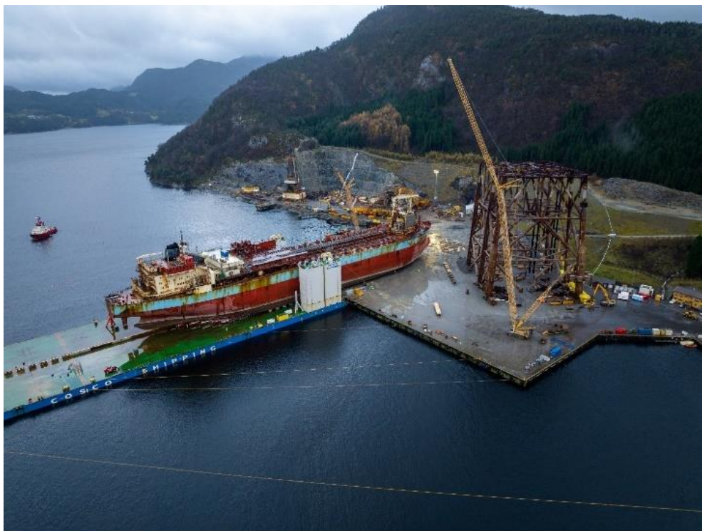
Figur 2-3 T.v. skipsanløp ved miljøbasen. T.h. innlasting av 230 m langt produksjonsskip
