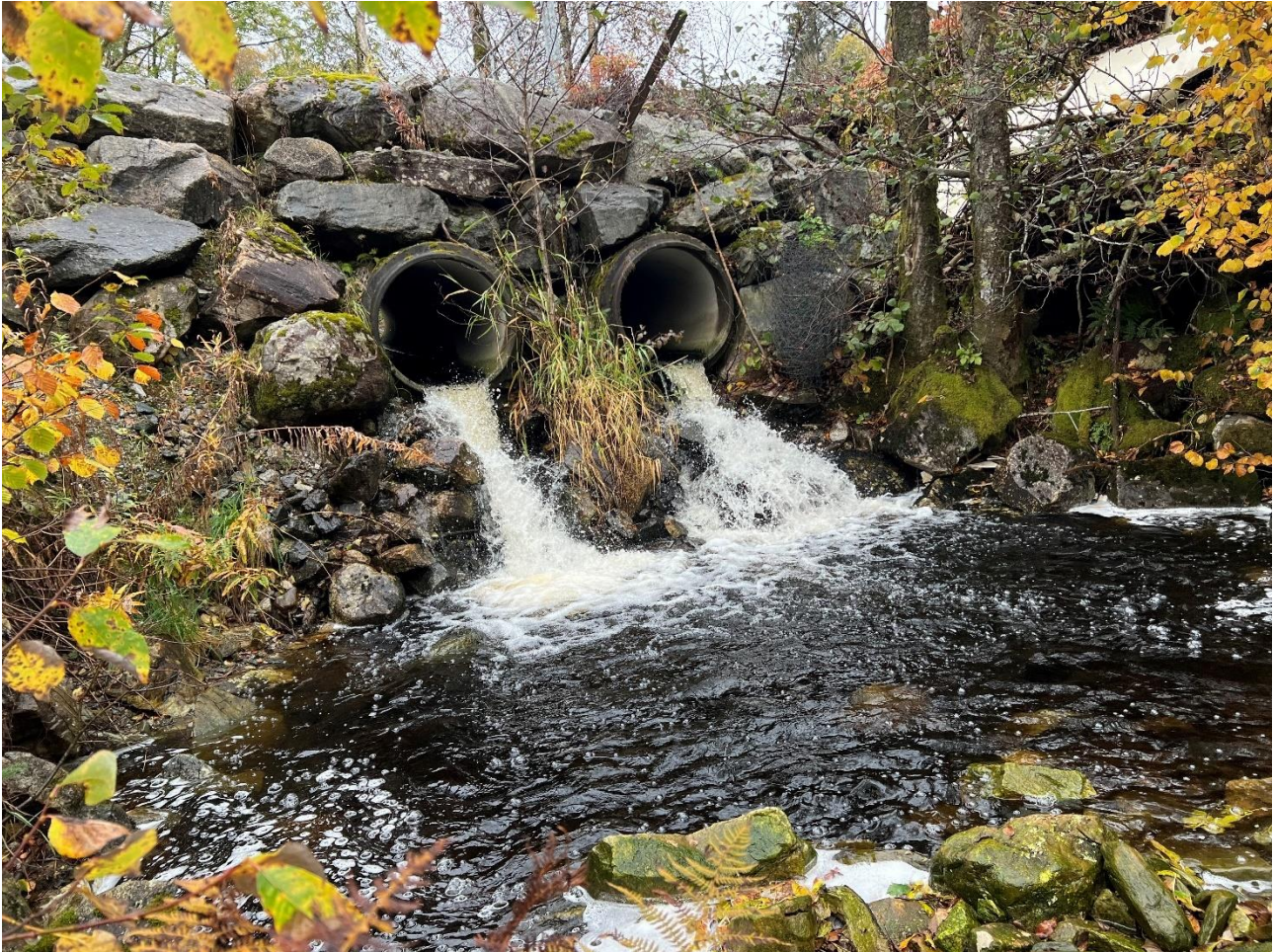
Figur 4-16. Kulvert 400 m oppstrøms Raudneselva.
