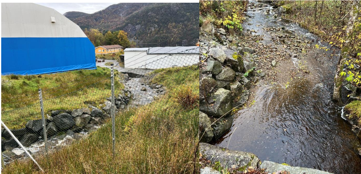
Figur 4-15. Bilde av Raudneselva der den går i kulvert ned under eksisterende anlegg ved Vats (t.v.) og et av få egnete gytepartier med roligere vannføring og grus rett nedstrøms kulverten 400 m opp i elva (t.h.).
