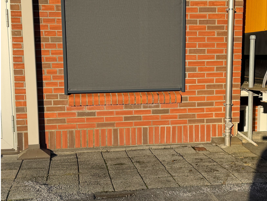
Bilde 4. Teglförblending med kun ett drensnull på ca. 2,5 m.
