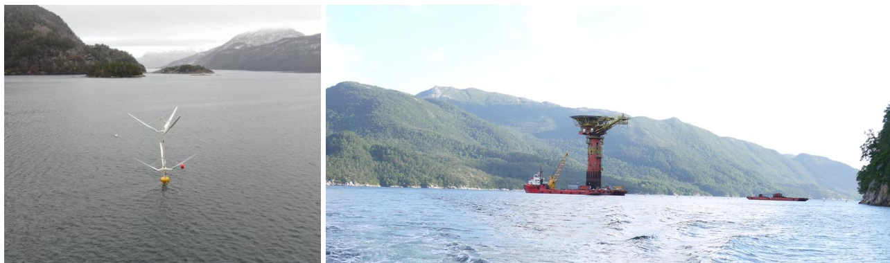
Figur 1-10. T.v. oppankring av flytende vindturbin i Vatsfjorden 2024. T.h. oppankring av SPAR-bøye med 134 m dypgang i Yrkefjorden
