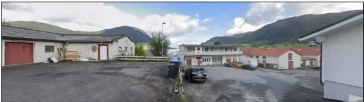
Bilde frå google maps som viser eksisterande bygningar som skal rivast.
