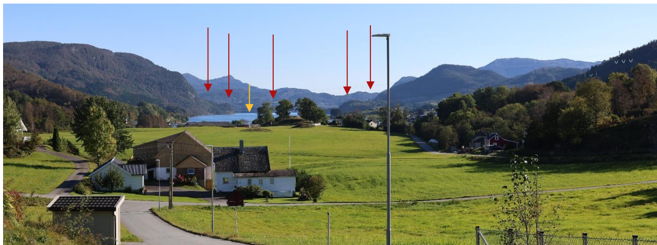
Figur 4-16 Bilde tatt fra dalføret nord for Vatsfjorden. Røde piler viser hvor vindturbiner vil stå lagret. Gul pil markerer område hvor fundamenter vil stå lagret.
