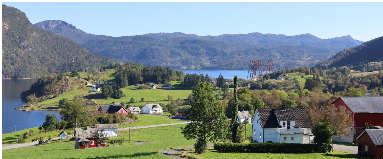
Figur 3-33 Gårdsbebyggelse og kulturlandskap på vestsiden av Vatsfjorden. Raudneset ses til venstre i bildet, og strekker seg ut i fjorden. Gamle rigger til dekommisjonering ses på anlegget til AF Offshore Decom ute i fjorden.
