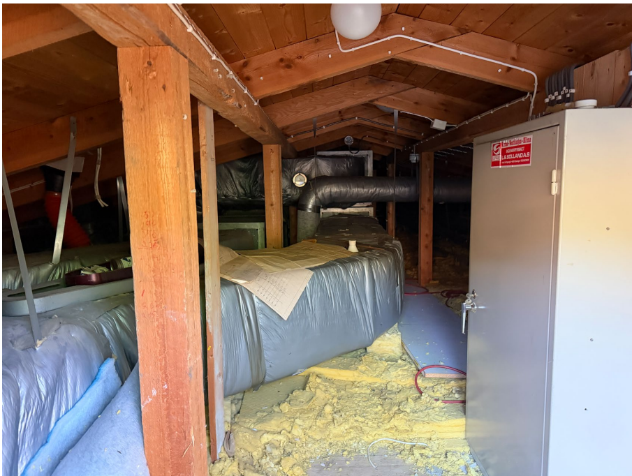
Bilde 16. Takkonstruksjon, 1961-bygget.
