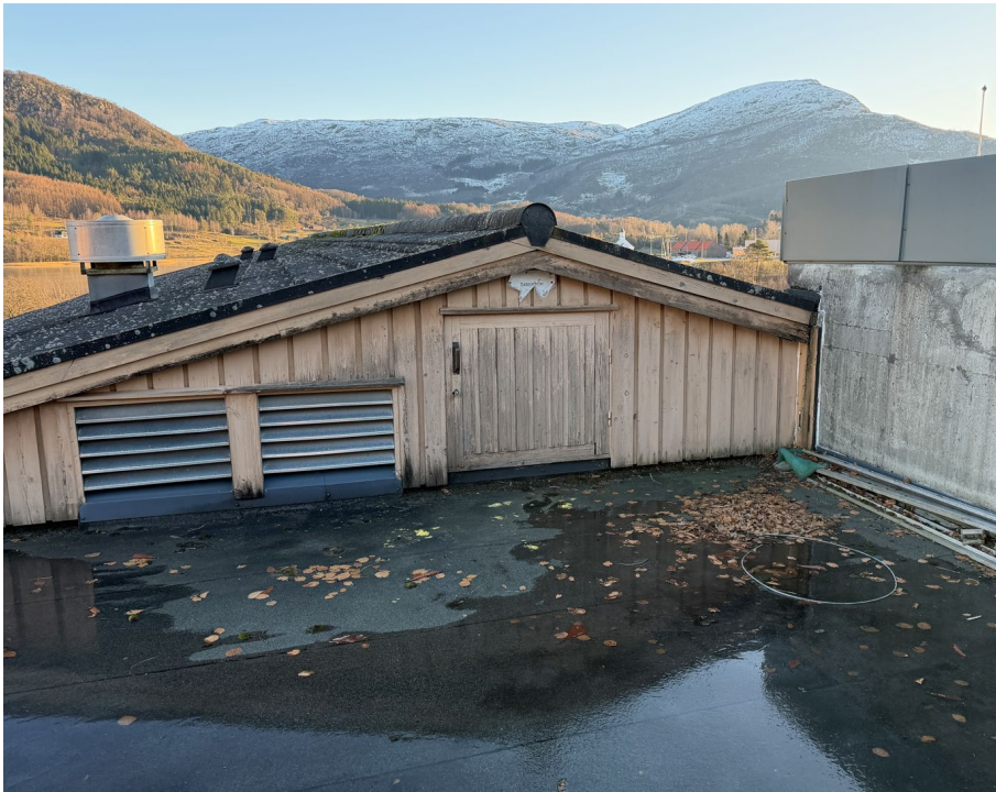
Bilde 15. Tak og tilkomst ventilasjonsaggregat til 1961-bygget.
