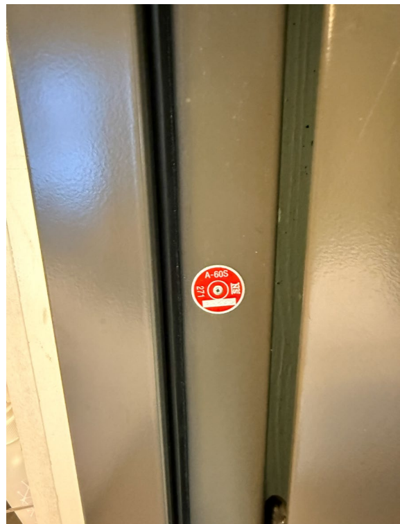
Bilde 61. Ståldør med A 60 S-klassifisering
