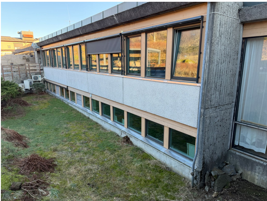
Bilde 7. Betongfasade, 1978-bygget.
