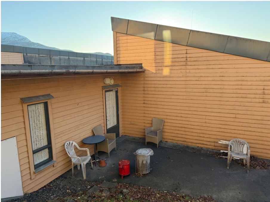
Bilde 8. Trekleddning, 1978-bygget. Kledning er ført ned på terrenget.
