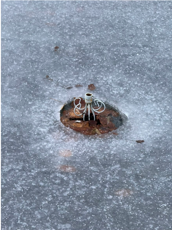
Bilde 31. Provisorisk rist montert sluk takvann.
