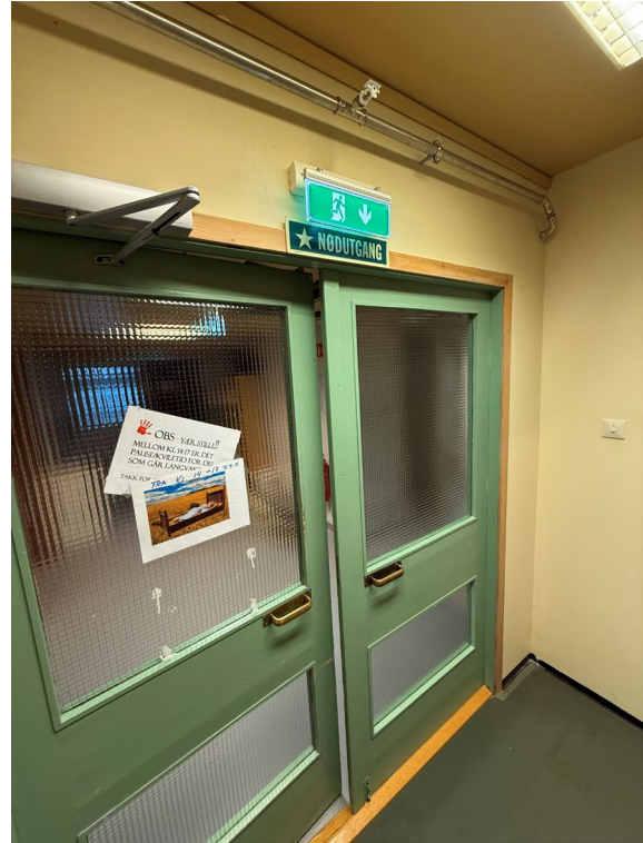
Bilde 55. Dør til rømningstrapp uten brannmotstand.
