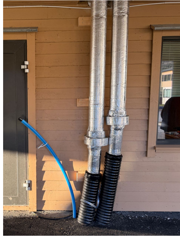
Bilde 34. Fjernvarmerør bør kasses inn.
