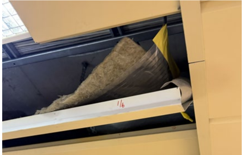
Bilde 36. Gammel strålevarme tak
