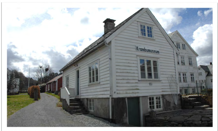
Krambumuseet i Ølen sentrum er opprinneleg eit bustadhus med ukjent byggjeår, men er sagt å vere det eldste huset i Ølen sentrum.
