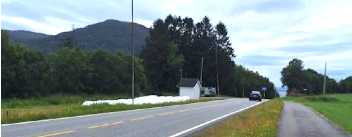
Figur 5. Bussholdeplassen Eiodalen. Holdeplass uten busslomme, men gang- og sykkelveg i bakkant. (Foto: Rune Sørheim 2024).
