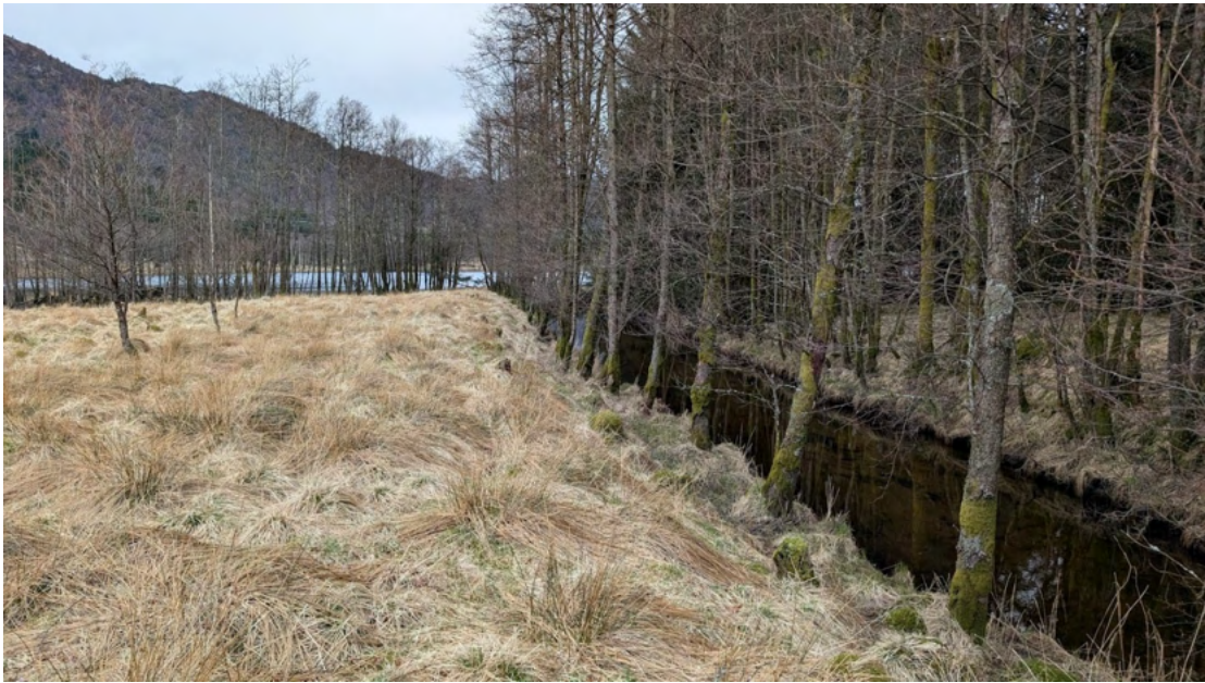
Figur 3-8. Foto av den gjennomgåande grøfta ved utløpet til Eikelandsvatnet.
