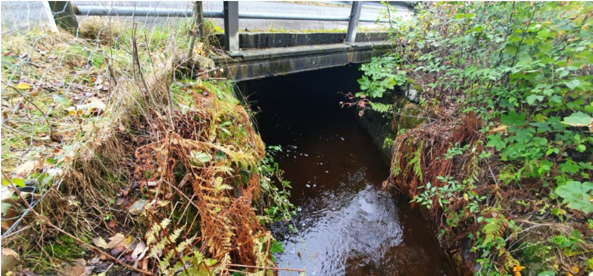
Figur 7-2- Bru 1, sett fra nedstrøms side
