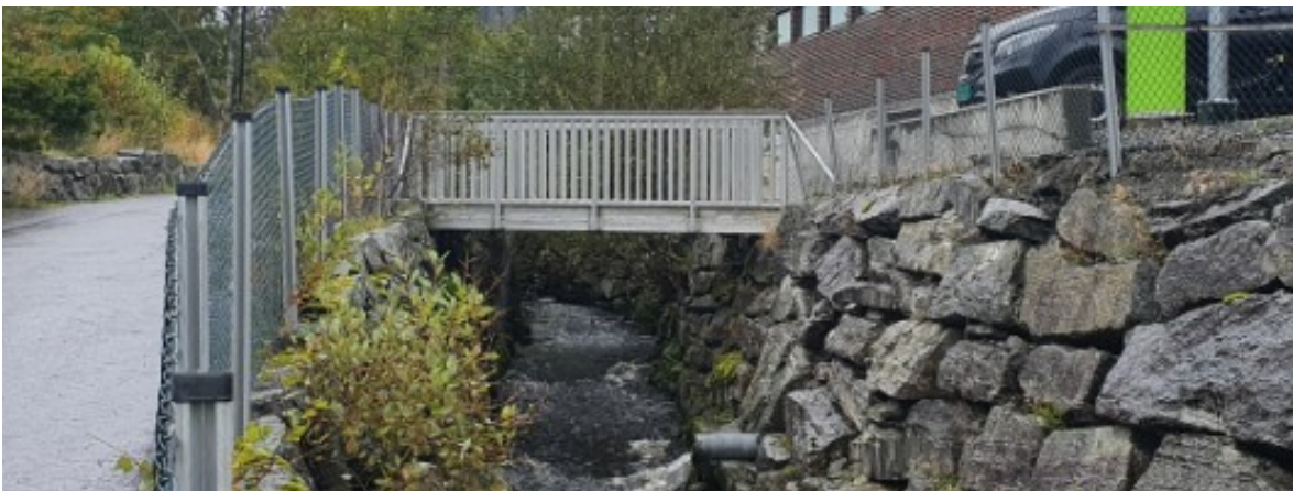
Figur 7-3- Bru 2, sett fra nedstrøms side
