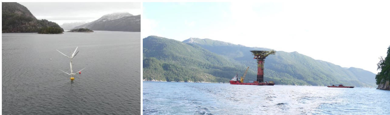
Figur 1-10. T.v. oppankring av flytende vindturbine i Vatsfjorden 2024. T.h. oppankring av SPAR-bøye med 134 m dypgang i Yrkefjorden
