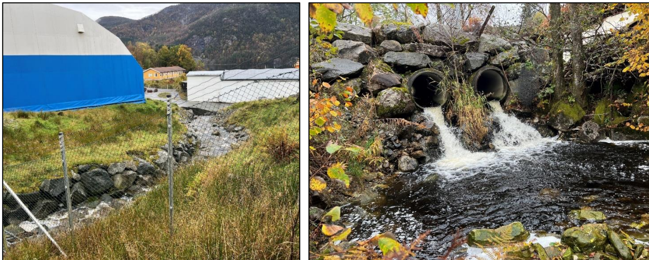
Figur 2-3: Bilde av Rauneselva der den går i kulvert ned under eksisterende anlegg ved Vats (t.v.) og kulvert ca. 400 m oppstrøms elva (t.h.). Begge bilder: Norconsult Norge AS 2025 [11].
