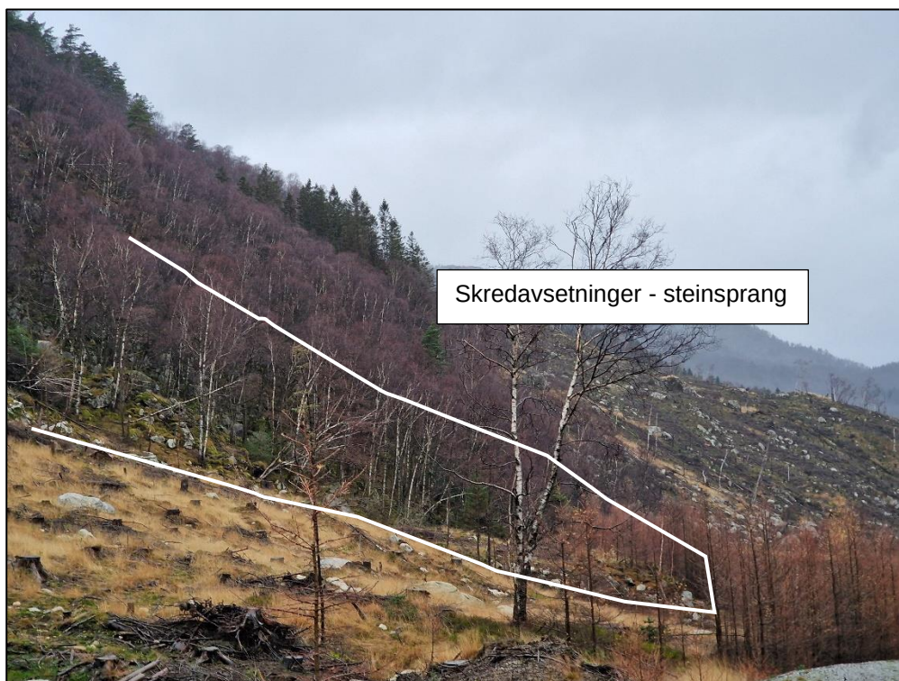
Foto 8: Skredavsetninger nedenfor løsneområde 2 rekker ned mot veg over toppkant skjæring. Foto mot NV.
