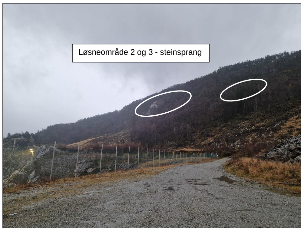
Foto 2: Oversikt over søndre del av kartleggings – og påvirkningsområdet (Foto mot SV).
