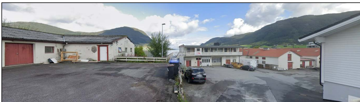
Figur 6: Bilde frå googlemaps som visar dagens bygningsmasse som skal rivast.
