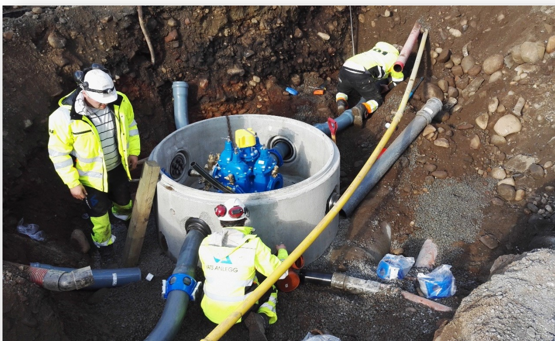
Ny vassleidning i Sandeidsjøen og sanering av ein gammal malmleidning i Sandeid Foto:Vindafjord kommune
