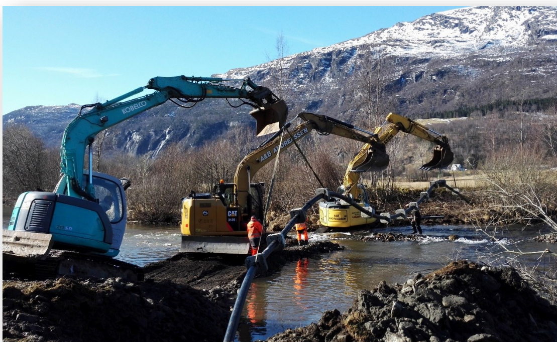
Ny vassleidning over elva i Vikedal . Foto: Vindafjord kommune
