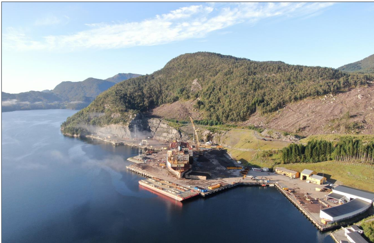
Figur 3-2: Foto av anleggsbasen i bruk (Kilde: AFOD)
