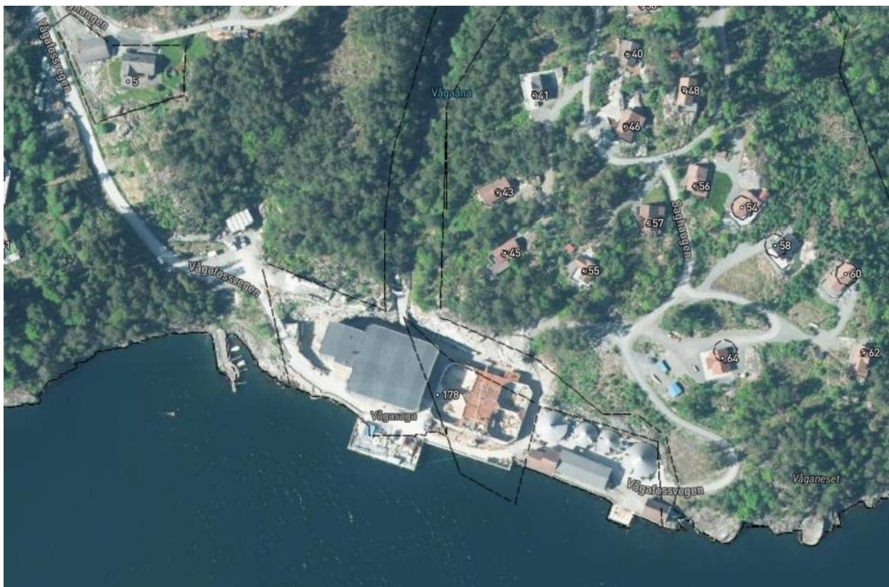
Flyfoto med dagens anlegg under oppføring.
