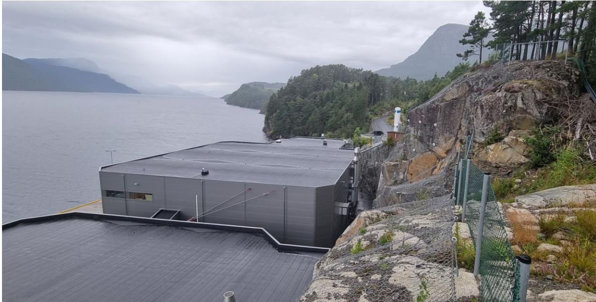
Foto som syner eksisterande skjeringskant med sikring.
